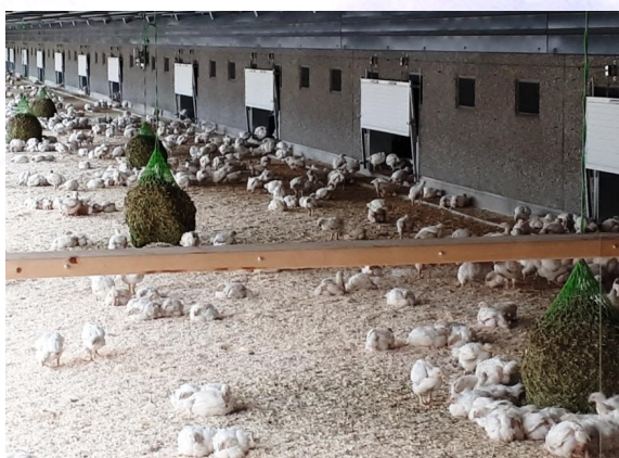
Udgangslåger i isolerede sandwichpaneler
