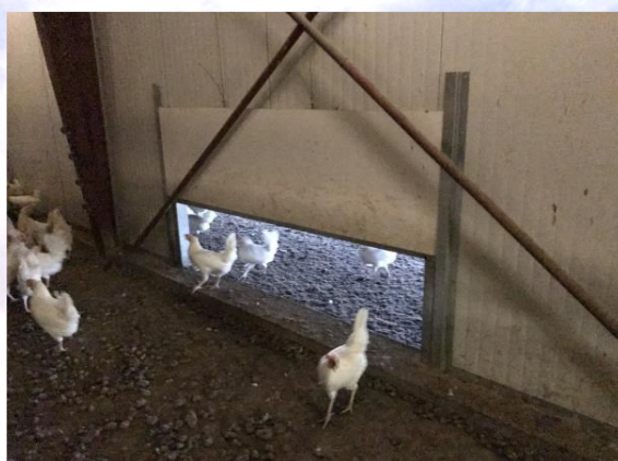
Udgangslåger i opskummet PVC-paneler
