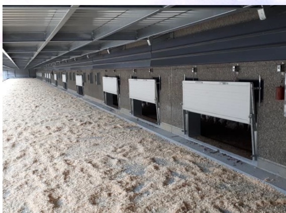
Udgangslåger i isolerede sandwichpaneler
